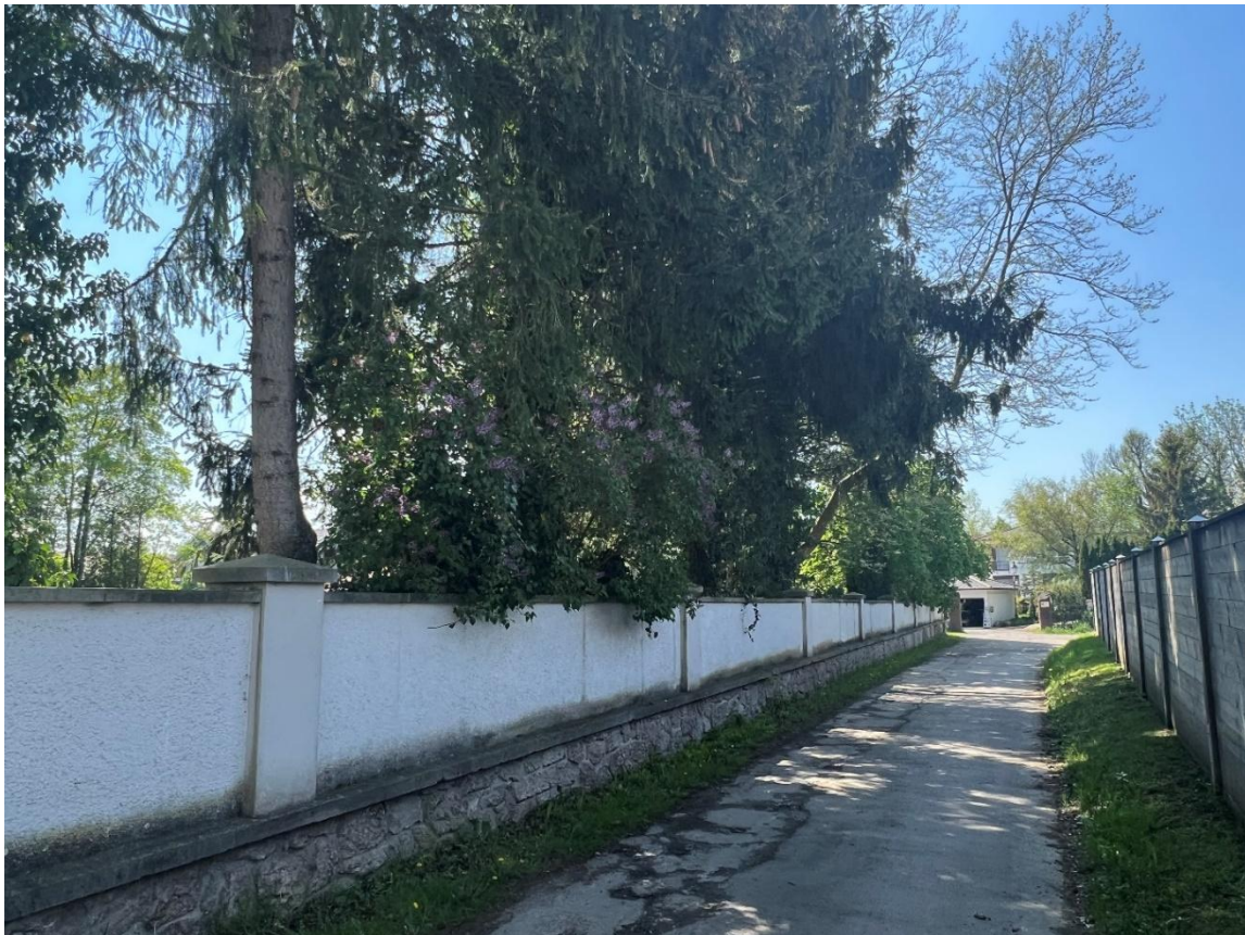
Abb.6: Foto Gartenmauer entlang der Stichstraße die abgebrochen werden soll
