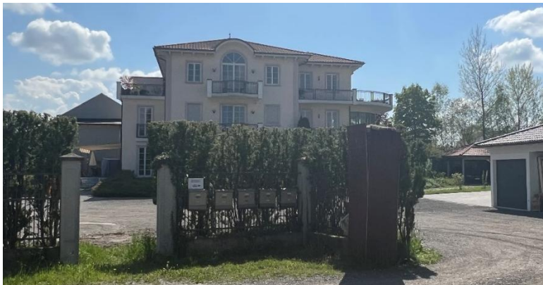
Abb. 8: Foto: Gebäude Hs.Nr. 16a: Wandhöhe: ca. 9,70 m
